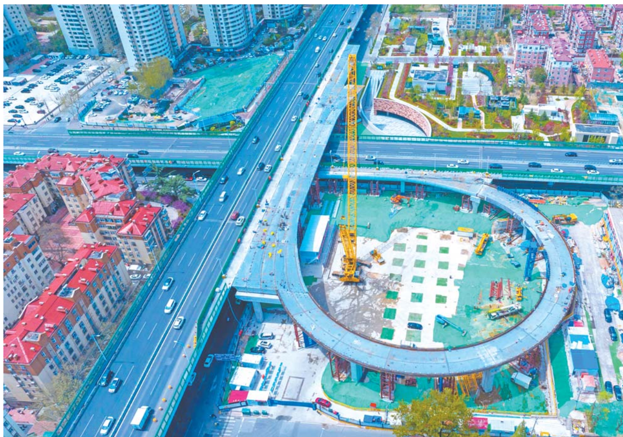
4月17日,山东路-鞍山路东北象限连接匝道桥钢箱梁全部架设完成。
