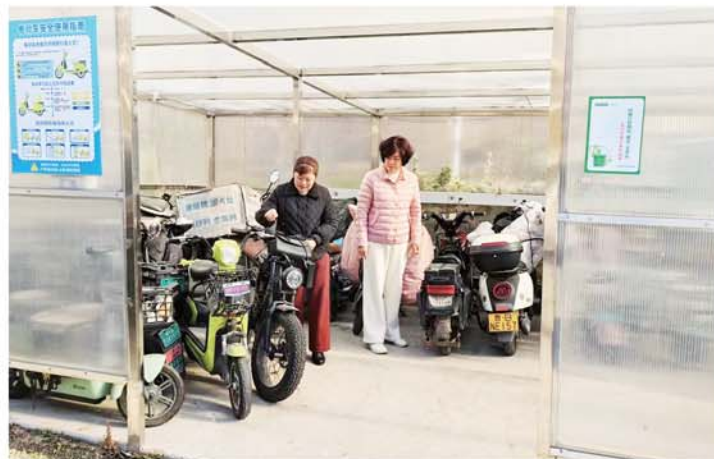
河崖社区德馨筑家小区电动自行车车棚建成投入使用。
