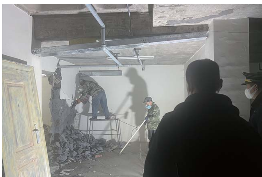
拆除地下车库违建。
