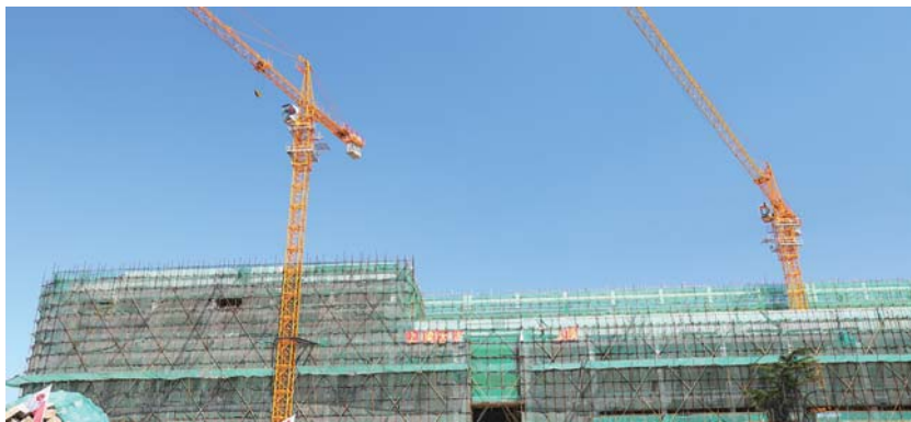
东怡增新材料产业园项目施工现场。
