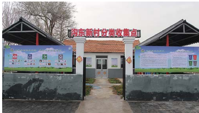
沟东新村垃圾分类收集点。
