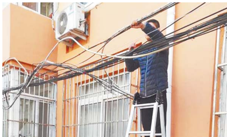
汕头路社区为居民修整电线。
