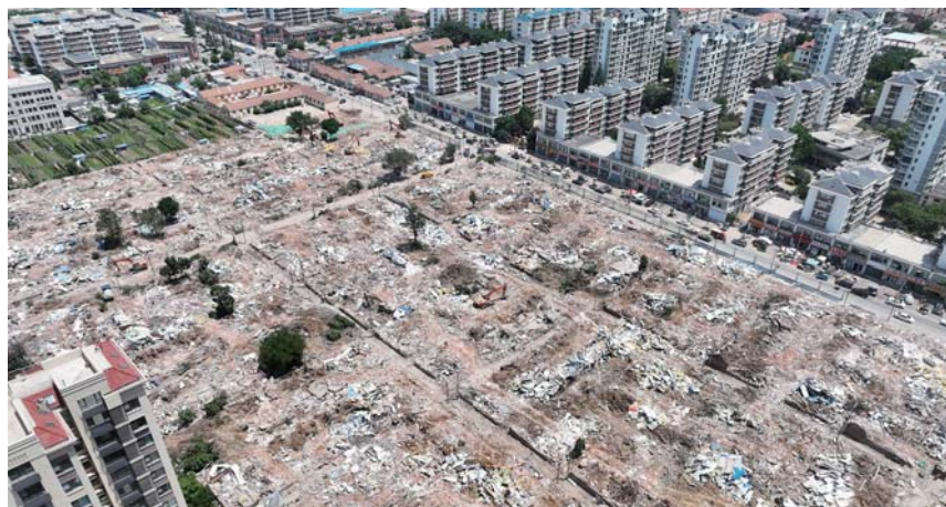
东荆社区仅用一天实现全部拆迁,创造了青岛社区拆迁的最快速度。
