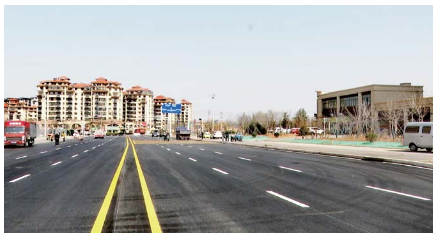
金院路南扩工程正式竣工并通车。
