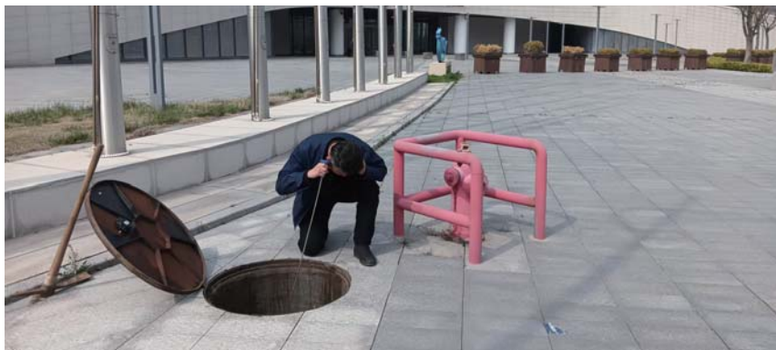
水务公司工作人员对现场进行管网巡查。
