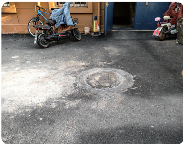
小区内6号楼污水井盖处已进行修理。
