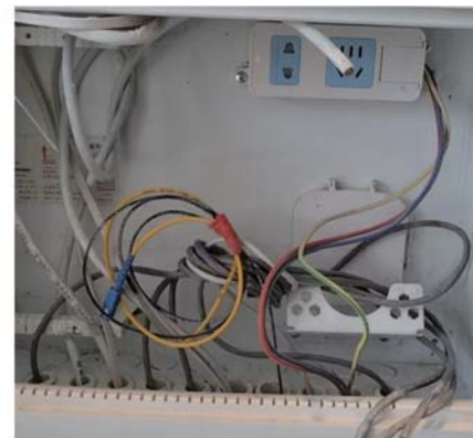
电源线未套管保护
