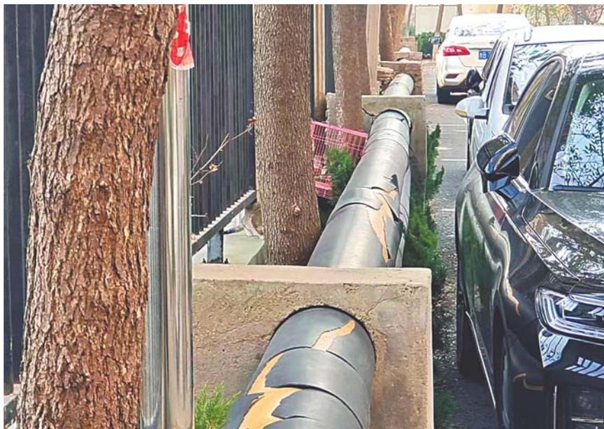
管网外皮发生大面积破裂。
