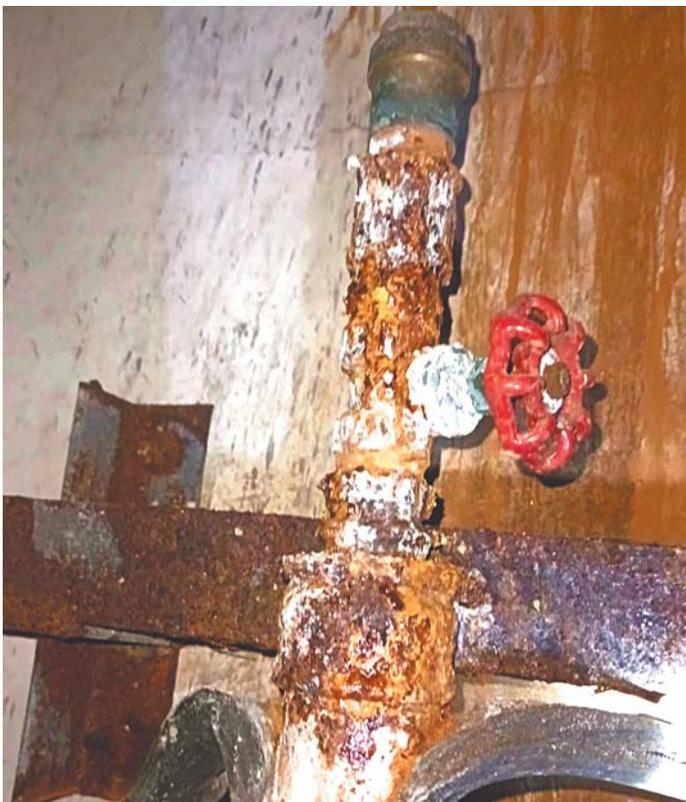
管道腐蚀、漏水严重。
