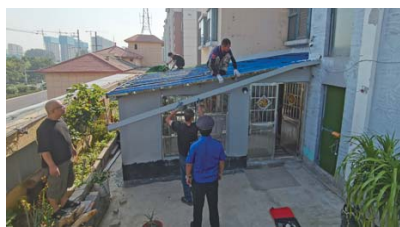
拆除违法搭建
