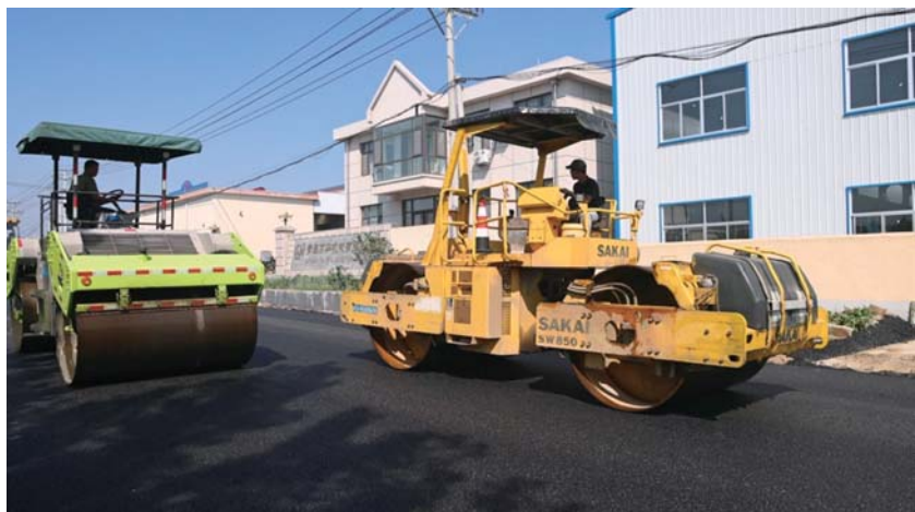
南挪庄—王相路项目整修现场。
