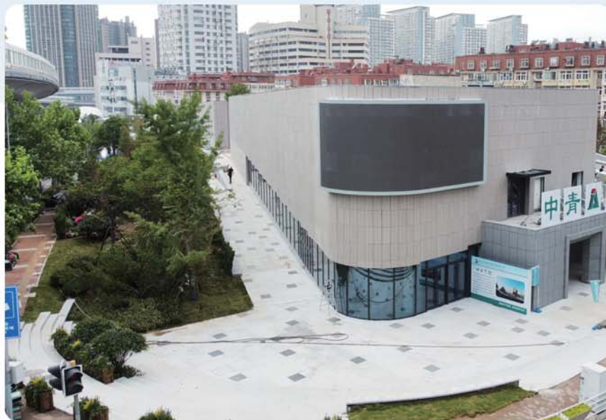
聊城路体育中心及社会公共停车场项目。
