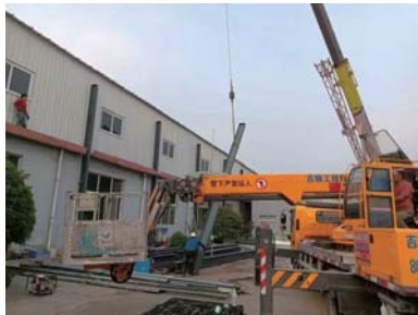
查力度,针对新生违建坚持即查即拆,保持高压态势。
