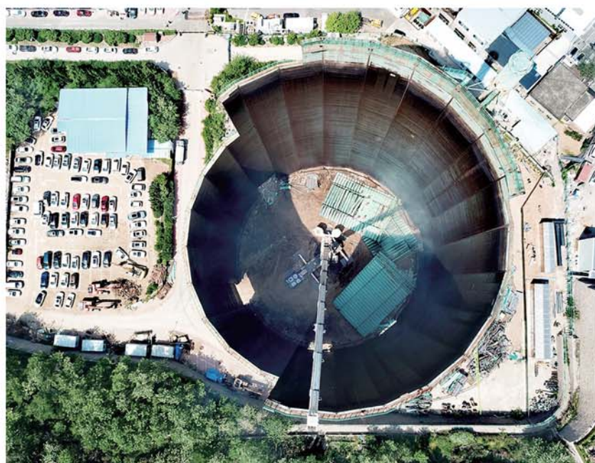
“大绿罐”内部露出真容。
