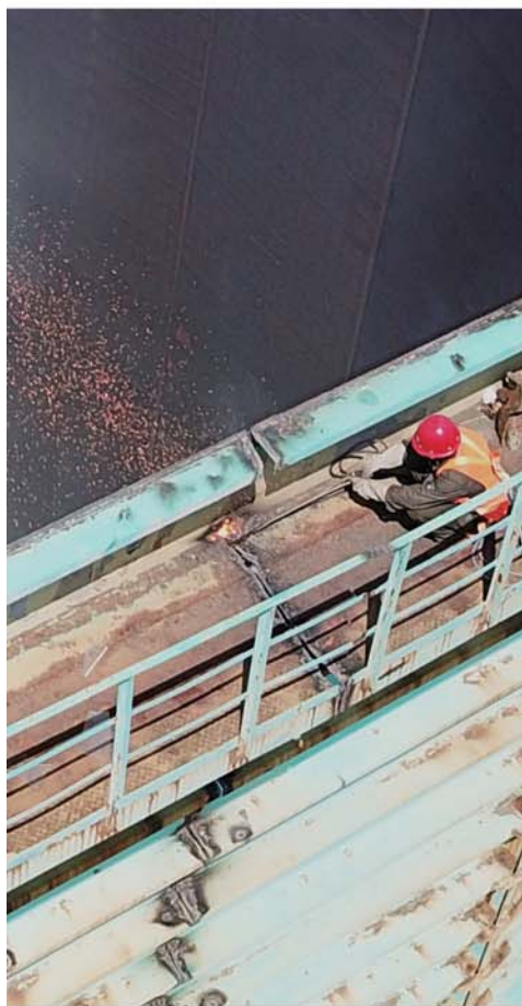
工人正在进行罐体高空切割作业。
