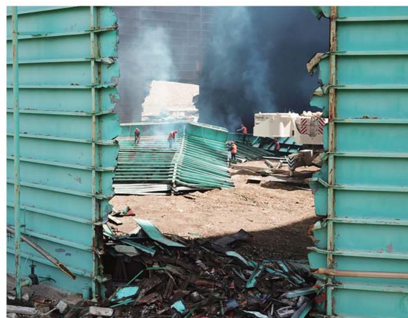
部分工人在罐体内部破拆运至地面的罐体钢板。
