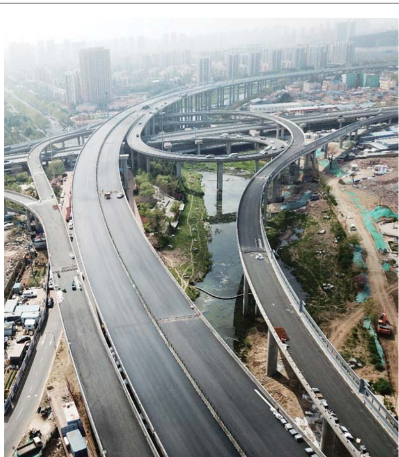
4月21日,新建高架路已经铺设好沥青路面。
