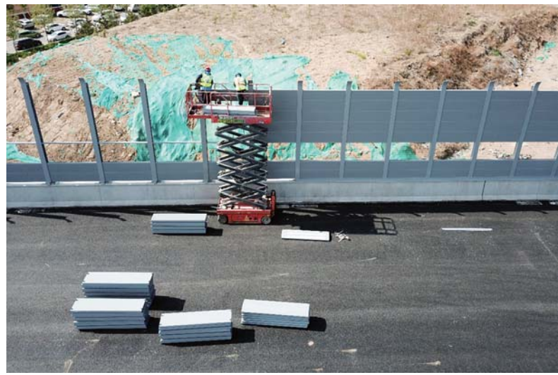
施工人员正在高架路上安装声屏障。
