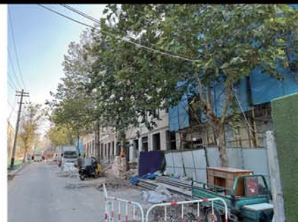
改造中的道路。
