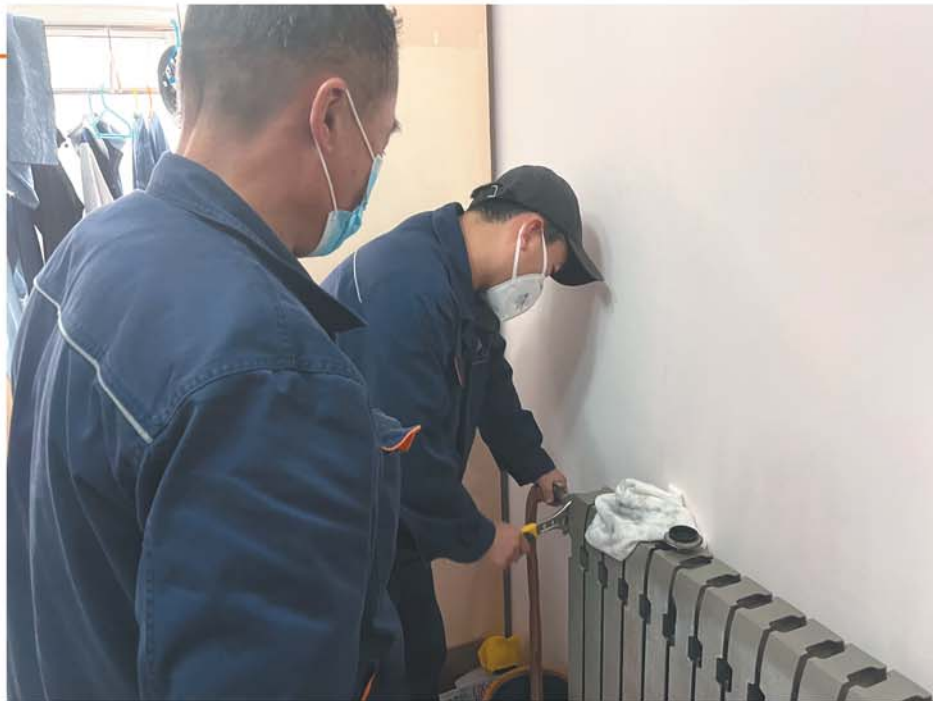
11月20日，廉民和同事正在给暖气片放水。
