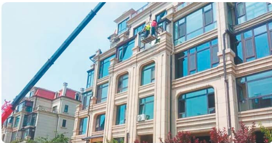
对海德堡君麓小区内存量违法建设依法拆除。
