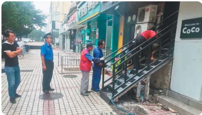
拆除存量违法建设，消除安全隐患。
