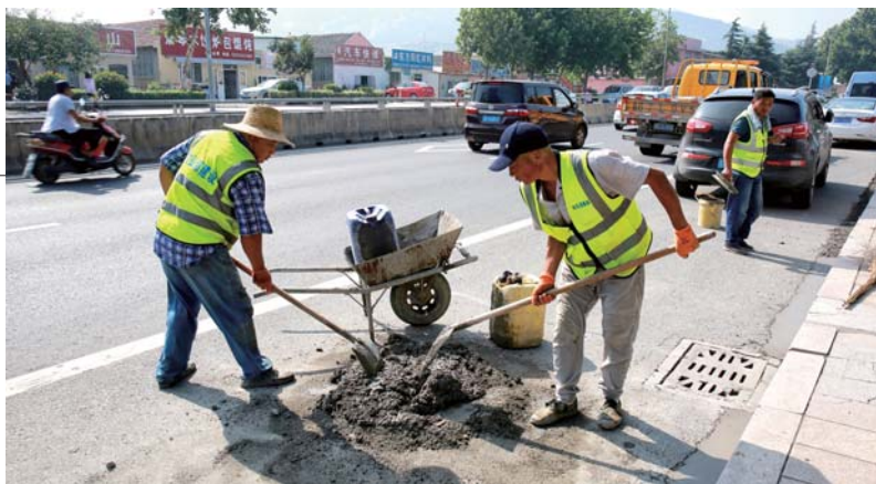
顶着烈日,工作人员忙着修整路面。
