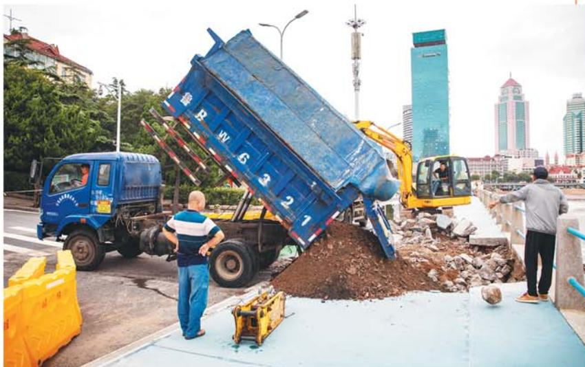
9月16日，西陵峡路海滨，施工人员正在对因台风受损的海岸线设施进行施工抢修。记者在现场看到，挖掘机与工程车配合协作，对相关受损路面进行填补处理。此外，有关部门还运来了新石板，准备对人行道上受损的路面进行修补更换。
