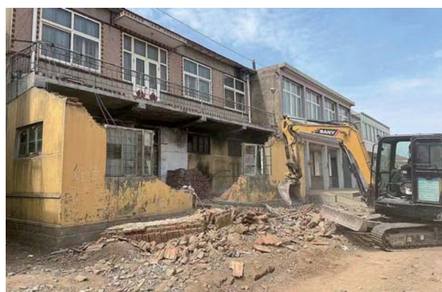
正在拆除违法建筑。
