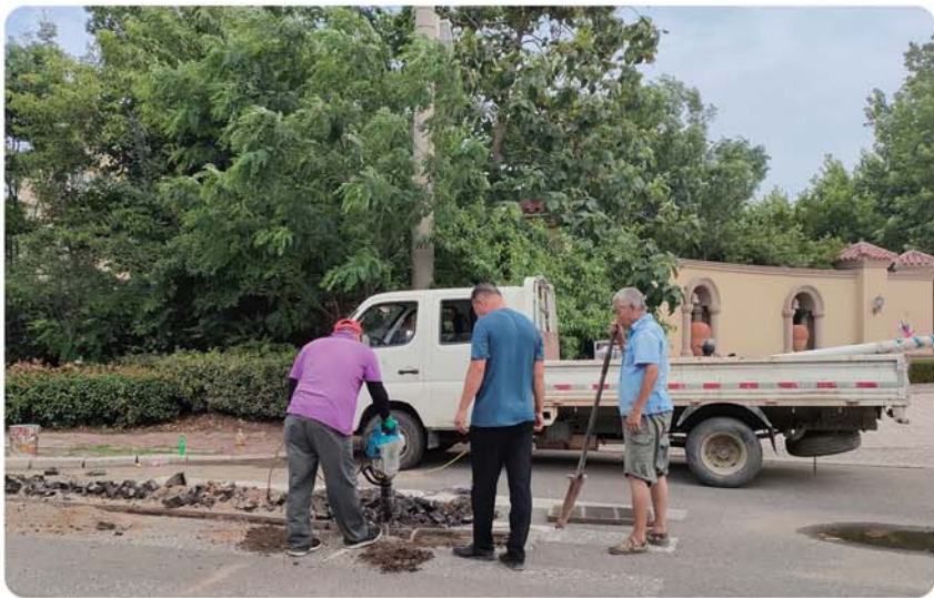
▲对路面不平、积水的道路进行重挖重修。
