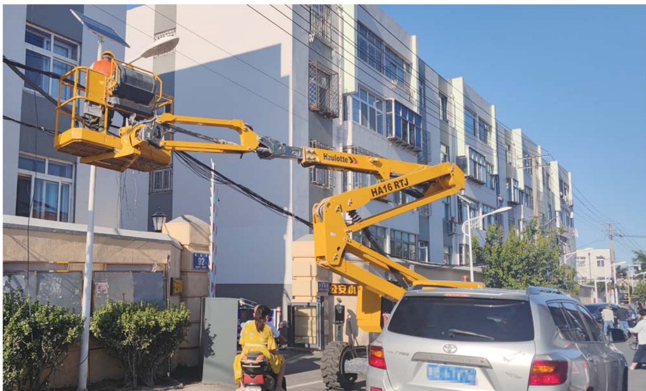
通济街道公安小区线缆整治现场。
