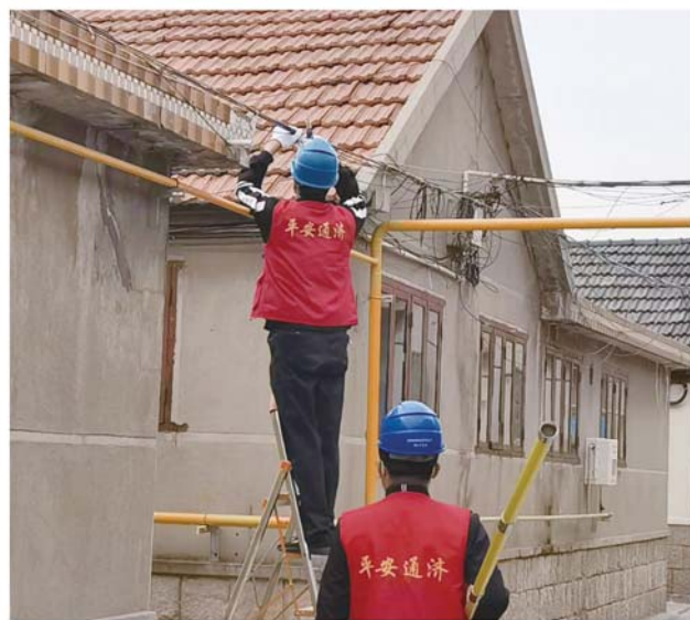
工作人员正在进行线缆整治。
