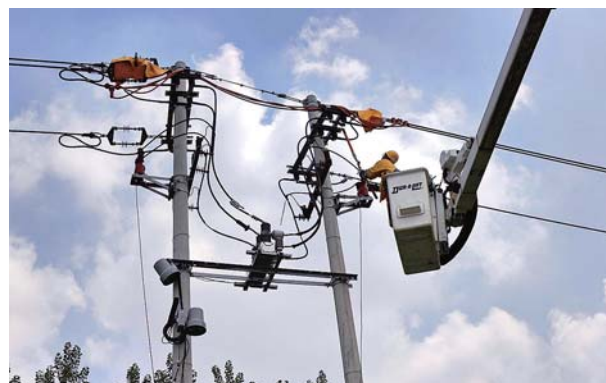
工作人员带电作业保正常供电。
