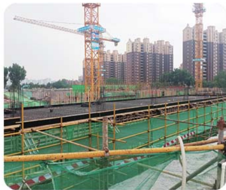
▲吴贾村社区安置区建设。
