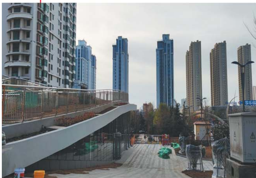
正在进行竣工验收的敦化路停车场,规划泊位400个。
