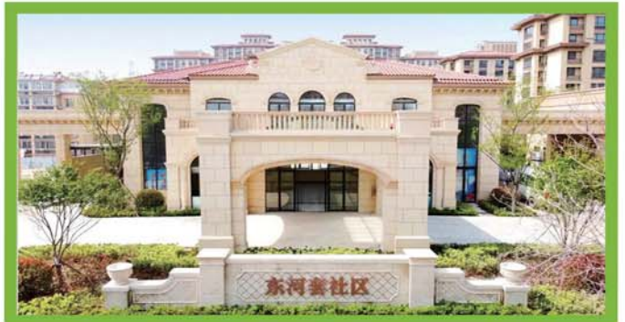
区住房城市建设管理局建立顶格推进机制，加快河套红岛区域旧村改造，托起居民安居梦。
