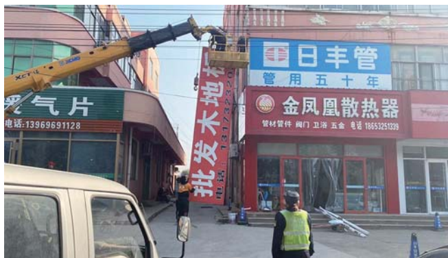
拆除沿街违规户外广告牌匾。
