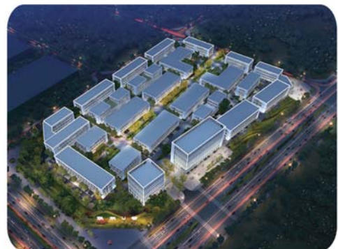
▲ 联东U谷即墨潮海智造港项目。
