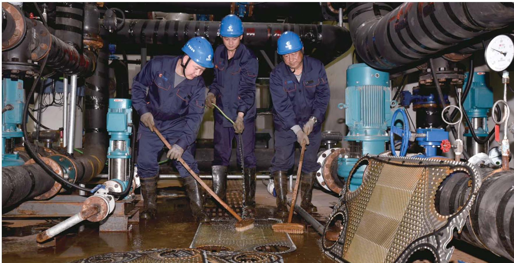
换热站检修现场。
