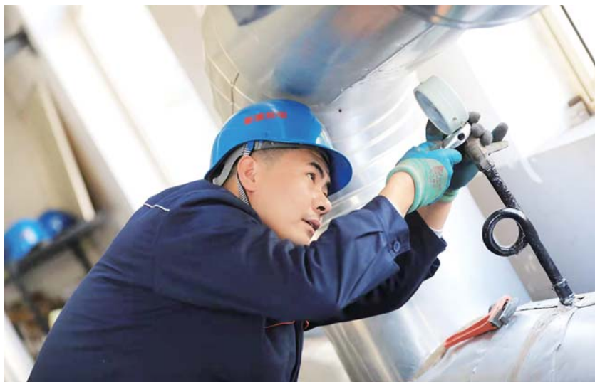
刘冲在对供热管网进行检查。
