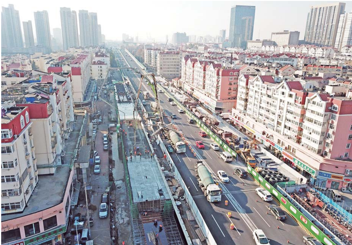
高架路原先路面两侧各增加一处匝道，施工车辆在浇筑混凝土。
