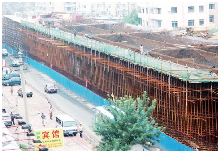
2006年杭鞍高架路新建时，记者记录下的相近路段施工影像。
