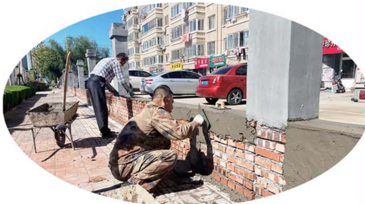
工人们正在进行金水花园外墙施工。
