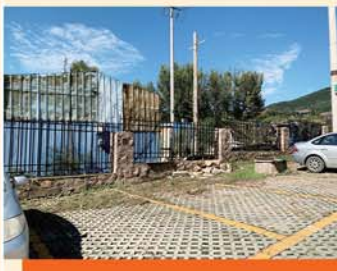
长润社区540米长的围栏由1.2米加高到1.6米。
