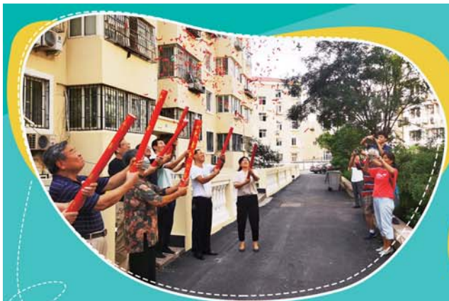
八大关街道兴安支路7号1号楼3单元电梯 开工仪式。仇慧璐 摄
