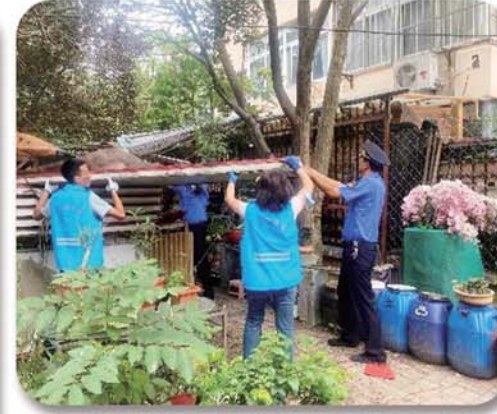
拆除私搭乱建。
