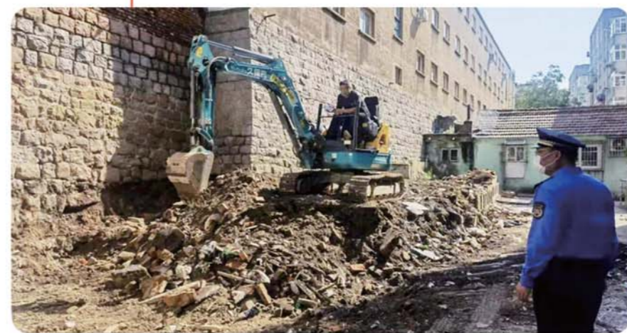
拆除废旧煤池子。
