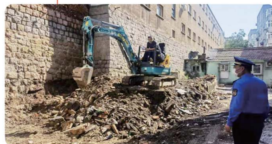
拆除废旧煤池子。
