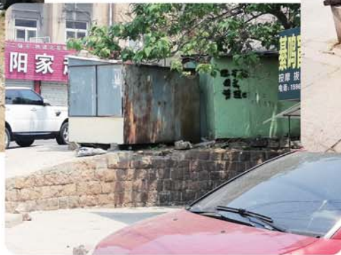
▼宜阳路开平路路口违法建筑。
