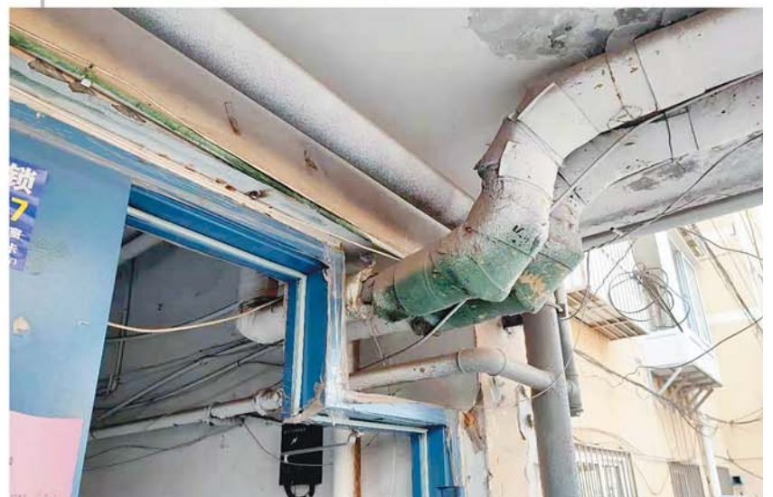
单元楼入口上方的管道。
