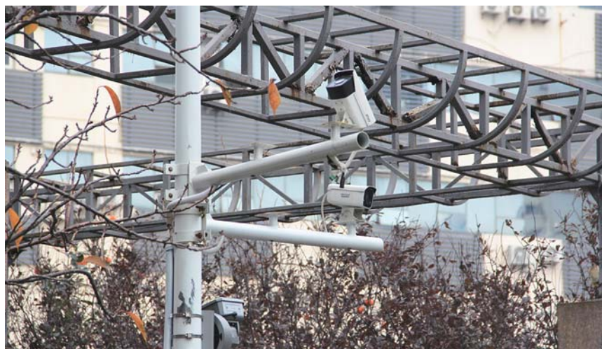
安装在小内的高空抛物摄像头。 郑钦泽 摄
