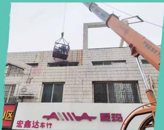
滨河路商业街拆除破损广告牌。
