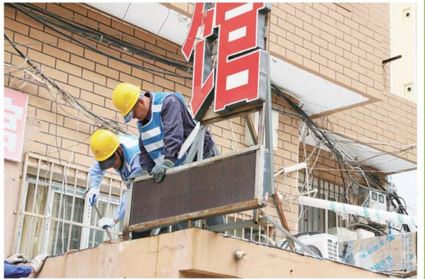
拆除违章广告牌。
