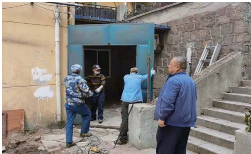
工作人员正在对违法建筑进行清理。
