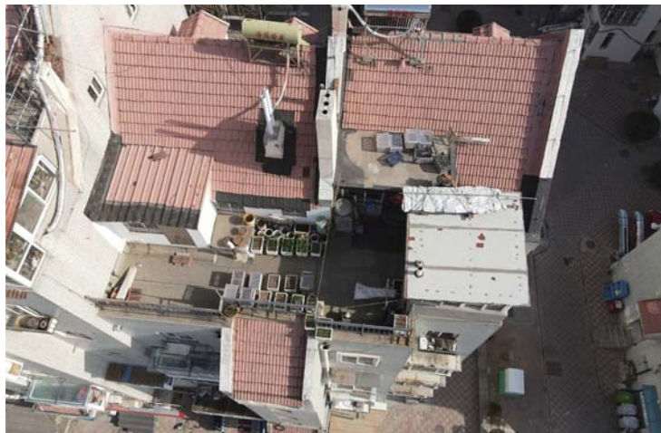
无人机对楼顶泡沫箱进行航拍。
