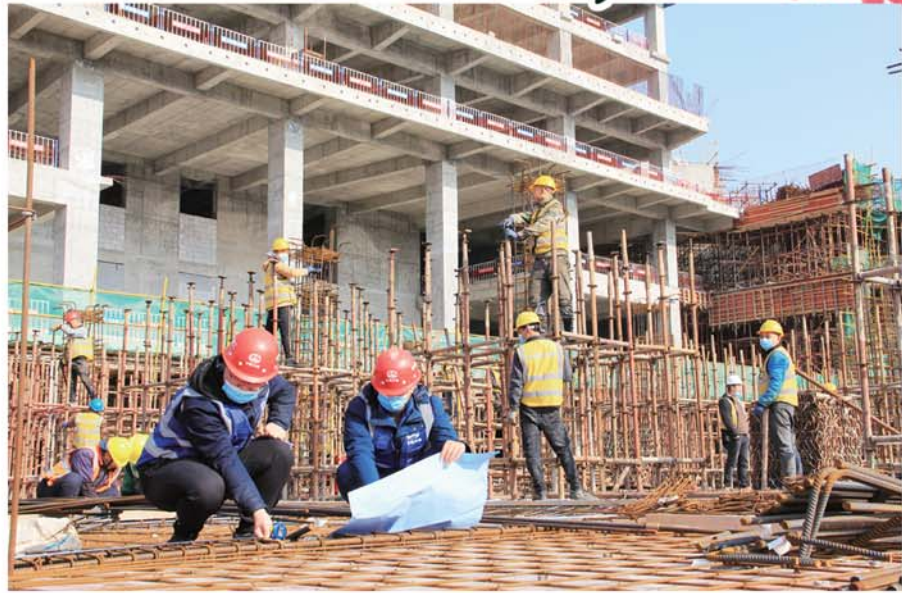
3月4日,百洋健康城市综合体项目施工现场。
