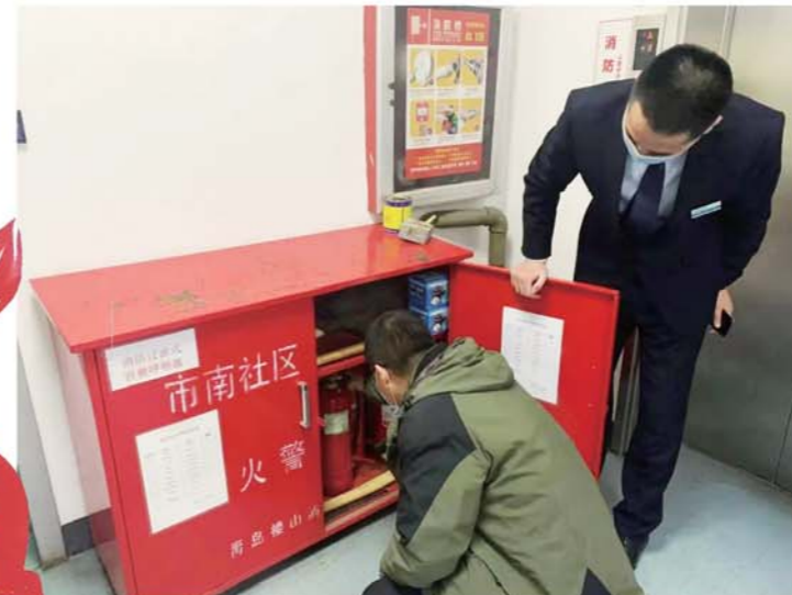
消防器材安全检查。
