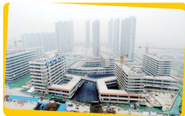
人才综合体项目建设筑巢引凤人才聚。
