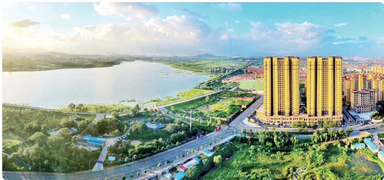
蓄势扬帆再起航，行稳致远新跨越。
