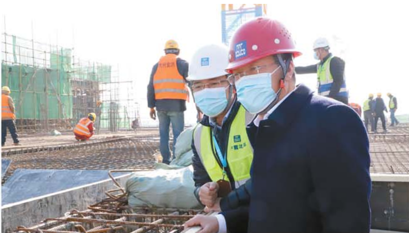
临近春节，曹凤新（右）在工地督导工人安全施工。
